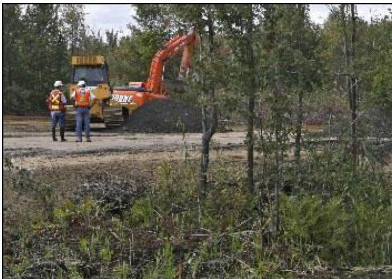
La construction du viaduc et de l'échangeur se fait en plein milieu humide. Au nord de l'autoroute 640, le terrain est en partie occupé par un marais, comme on peut le voir sur la photo. Photo Patrick Sanfaçon, La Presse
